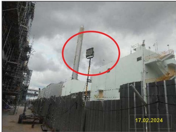
ค) กันเขตพร้อมติดตั้งไฟส่องสว่างบริเวณพื้นที่ก่อสร้าง
